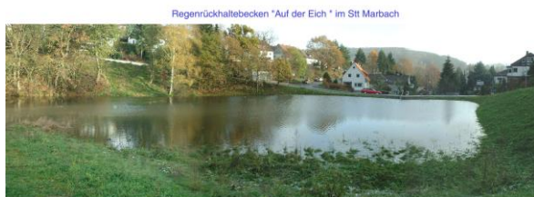
Regenrückhaltebecken "Auf der Eich" im Stt Marbach
